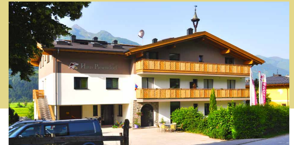
Das Haus Piesendorf verfügt nach dem Umbau über ein zusätzliches Stockwerk.
